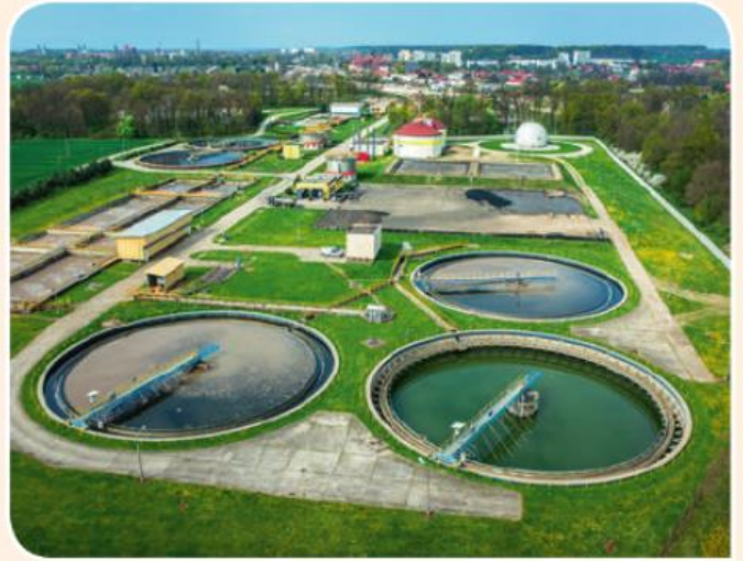
Une station de traitement de l'eau en France
